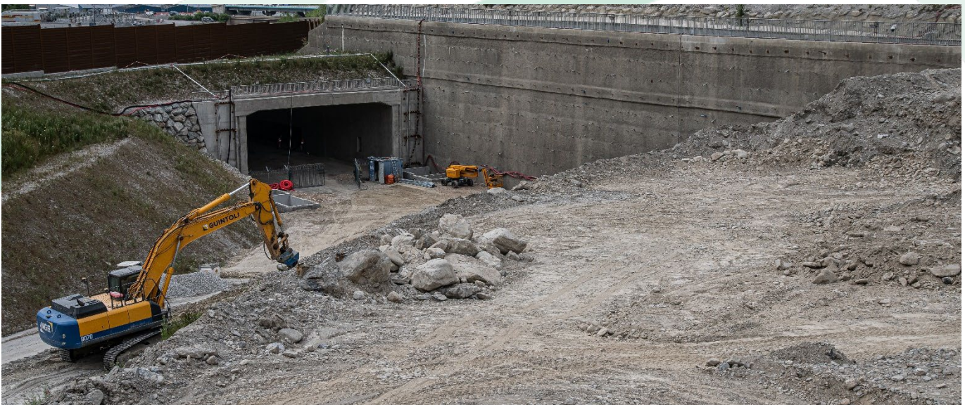
Travaux de terrassements
