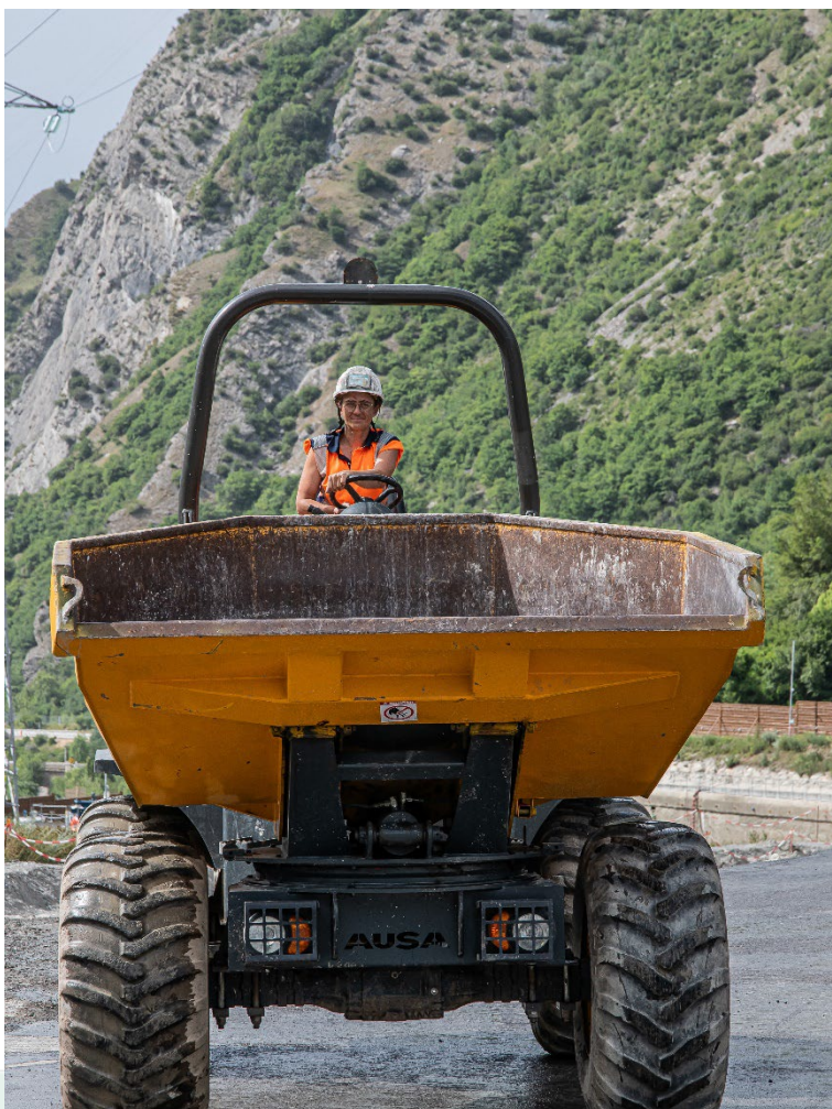
Conductrice d'engins – chantier Saint-Julien-Montdenis
